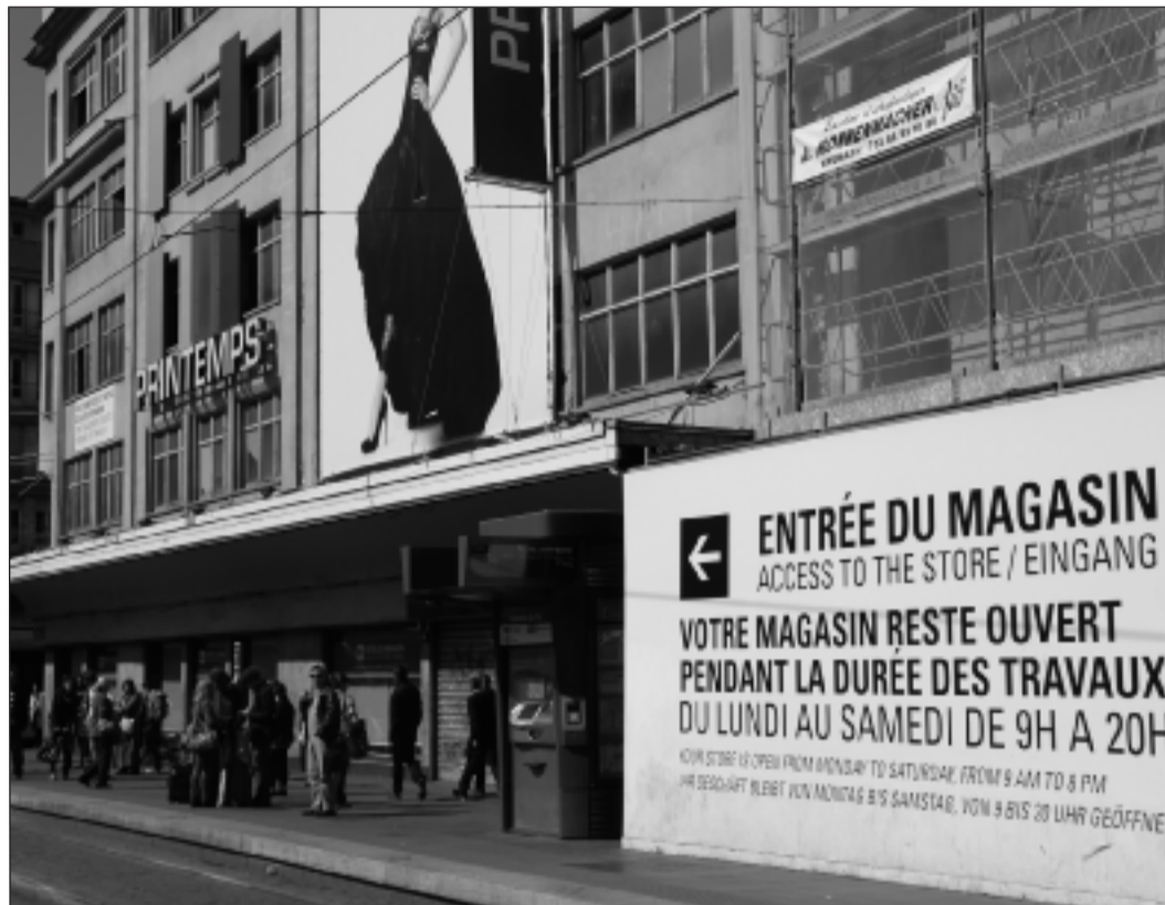
Le Printemps et les Galeries Lafayette se refont une beauté. Le montant des travaux s'élève à 23 millions d'euros.
