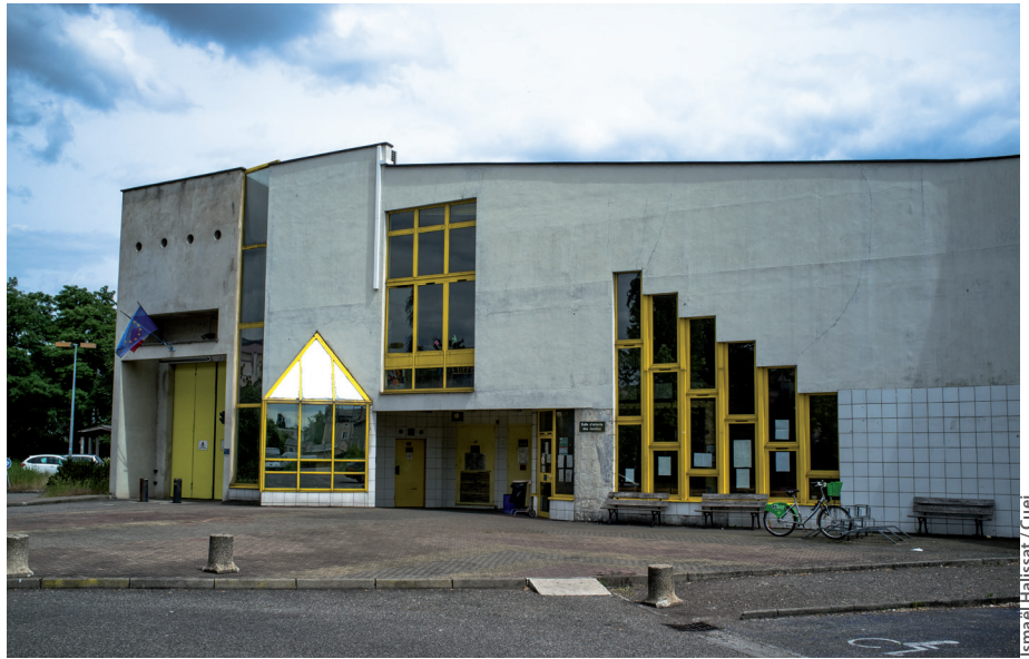
■ La maison d'arrêt de Strasbourg, située dans le quartier de l'Elsau, a été construite en 1988.
