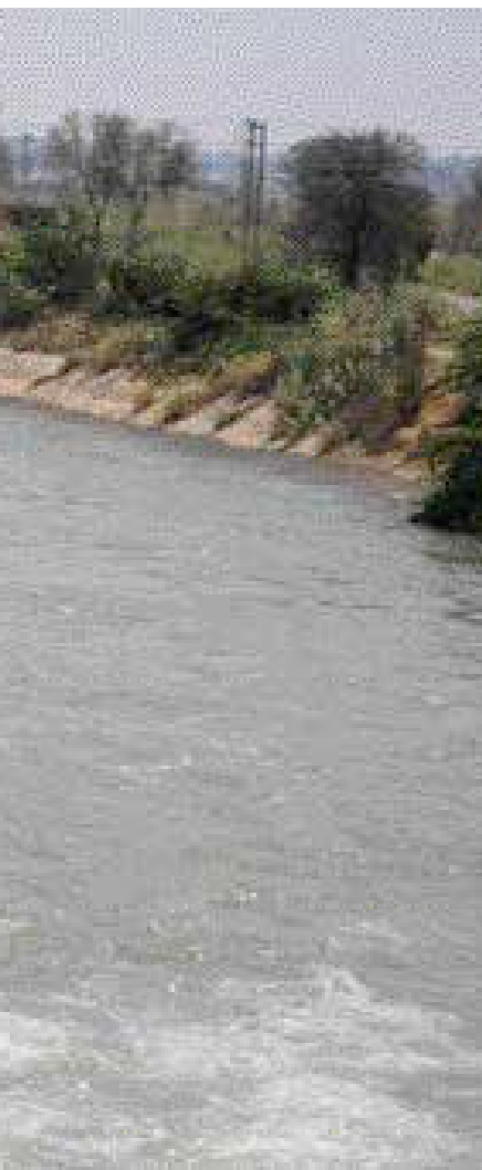
Le barrage de Munak dans l'Haryana, où une partie de la Yamuna est dérivée dans le CLC (Carrier Line Channel) pour rejoindre Delhi.
