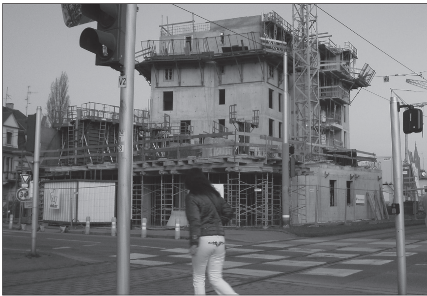
Un HLM en construction place du Schluthfeld.
